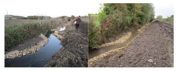
Restauration du lit du Grouet par mise en place de banquette et talutage de berge
