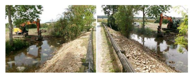
Travaux de talutage de berge à la fin des travaux sur le site de la Dactière (100 ml)
