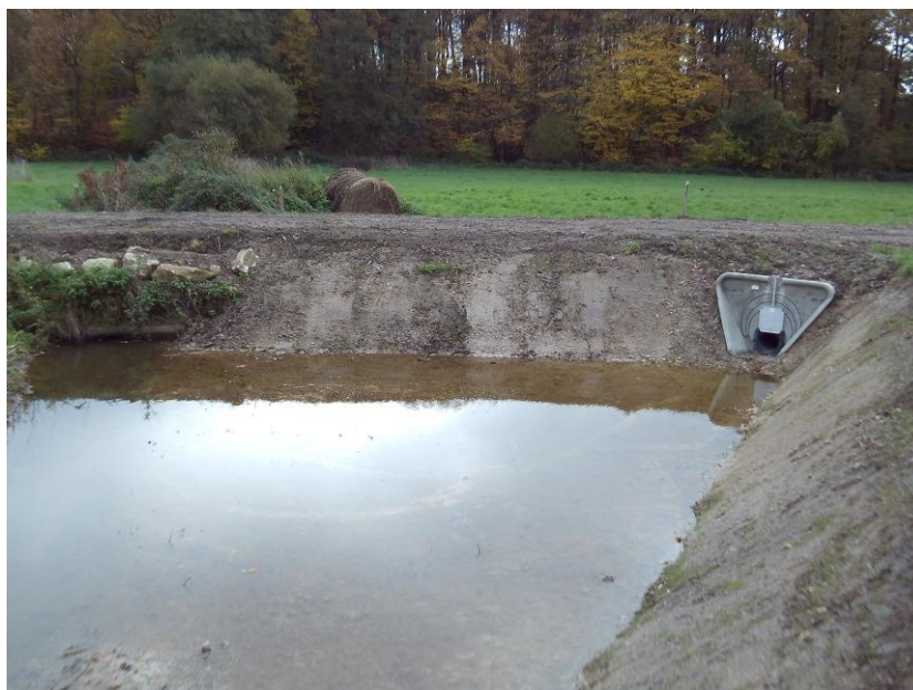
Sites tampon permettant de dévier les eaux vers la prairie à droite au niveau de la nouvelle buse posée...pour un tamponnage supplémentaire
