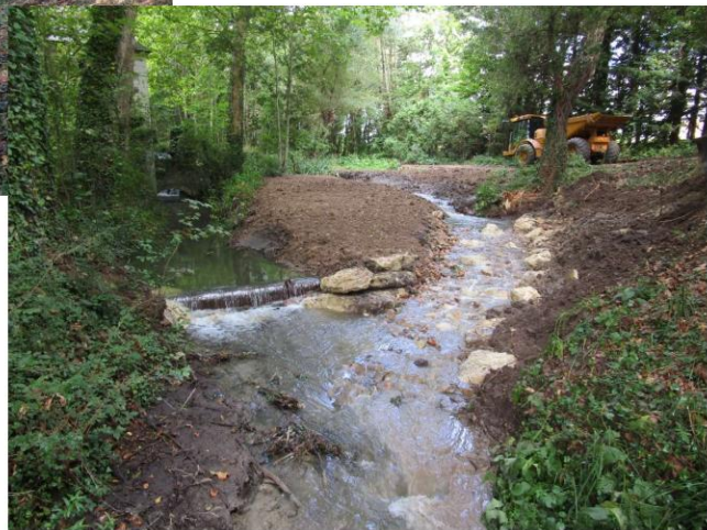
Photos avant/après sur le site du moulin Berteau à Pussigny
