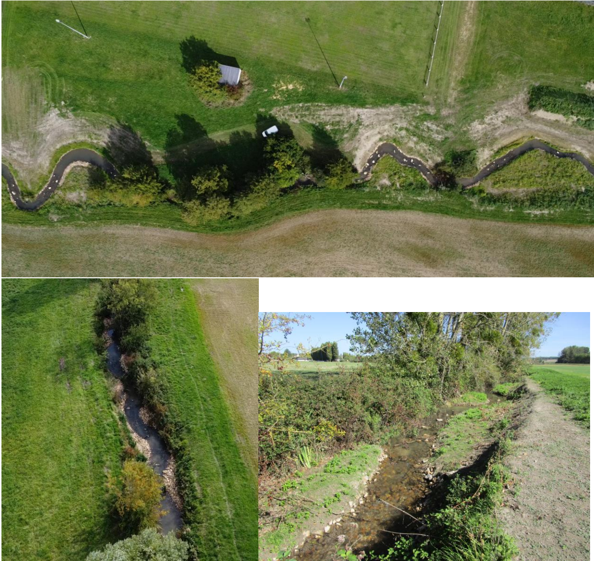
Travaux morphologiques sur le Réveillon à Nouâtre et Maillé réalisés en 2025
