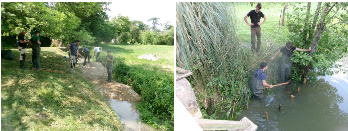
Chantiers de réalisation
