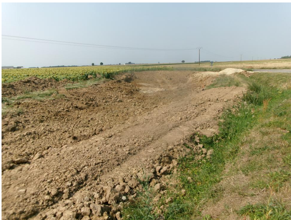
Réalisation d'un site tampon en cours
