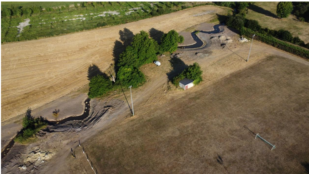
Travaux de reméandrage du Réveillon - été 2025
